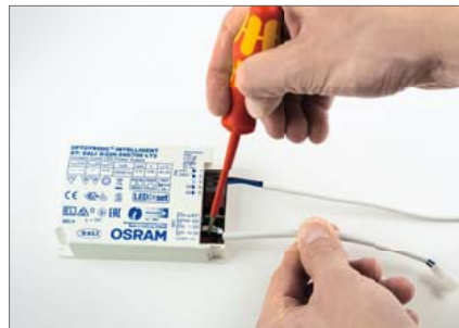
Étape 2: Reconnectez les câbles au convertisseur DALI
