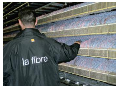
Installation d'un NRA par Orange.
