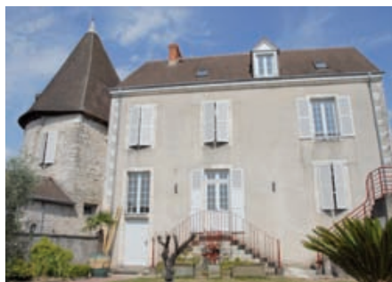
En rénovation – IHABITATION à Saint Lys (31).
