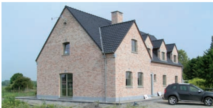
Dans le neuf – DOMO LOGIS TEC à Vieux Condé (59).
