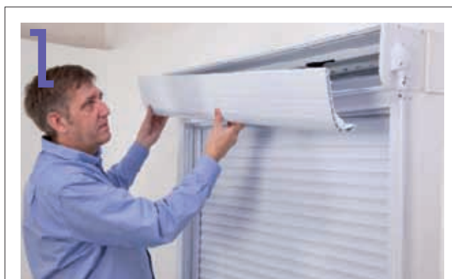
Montez le volet à son maximum puis descendez-le en comptant le nombre de tours de manivelle.
