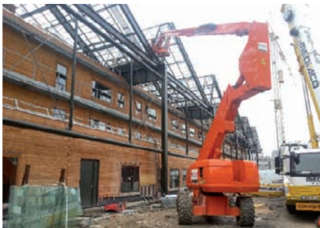
L'exposition des chantiers aux vols, une vigilance de tous les instants.
