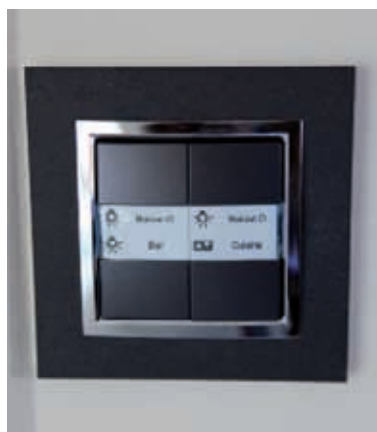
Kalysta Minerva de Hager finition ardoise avec variation de lumières, chauffage et volets roulants.
